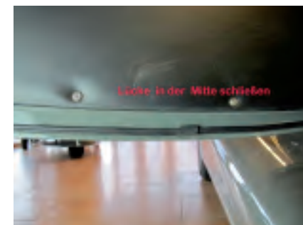
■ Abdichtung an der Tür
